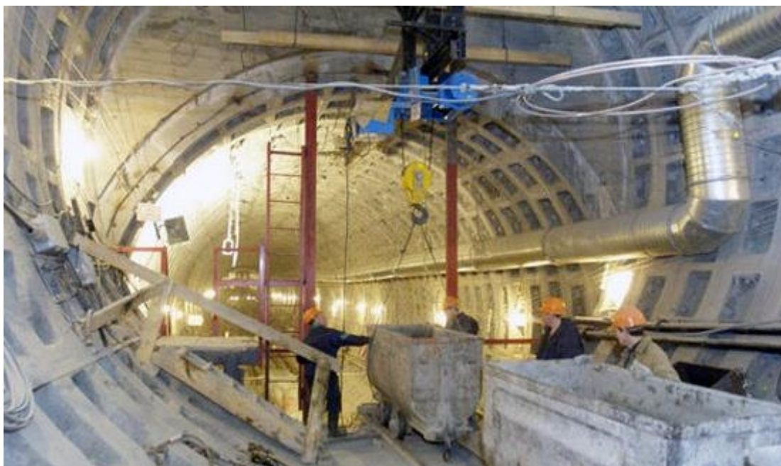
16 - сурет. Тоннельдерді жерасты тәсілімен салу кезіндегі маркшейдерлік жұмыстар
