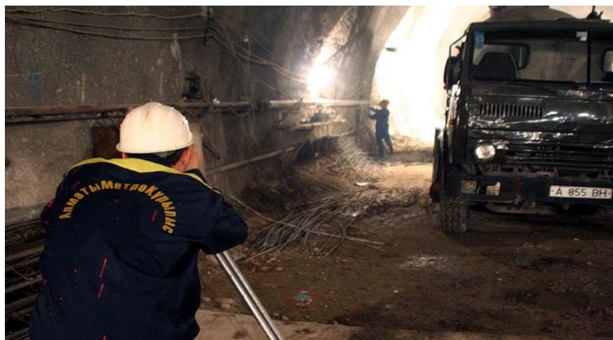
15- сурет. Жер астындағы маркшейдерлік түсіріс
